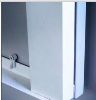
Die Führungsschienen lassen sich beim tiefgefahrenen Rollladen manuell ausstellen bzw. nach außen klappen. So bietet sich eine gute Lüftungsmöglichkeit bei gleichzeitigem Sichtschutz oder der Blick bei geschlossenem Rollladen beispielsweise vom ersten Stockwerk nach unten auf die Straße.
