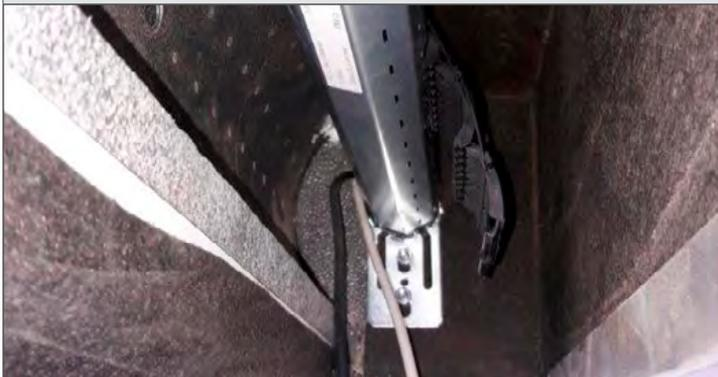
Welle im Kasten platzieren; Motorseite mit Klammer fixieren; Teleskopseite in Kugellager einführen und mit Schraube fixieren.
