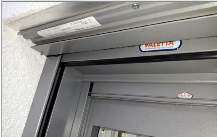
Montageclips für Abrollleiste auf Fenster bzw. ISR Führungsschiene montieren und Abrollleiste aufklipsen. Schlitzabdeckung anbringen und final nochmals den Panzer auf- und abfahren um den Lauf des Behangs zu kontrollieren.
