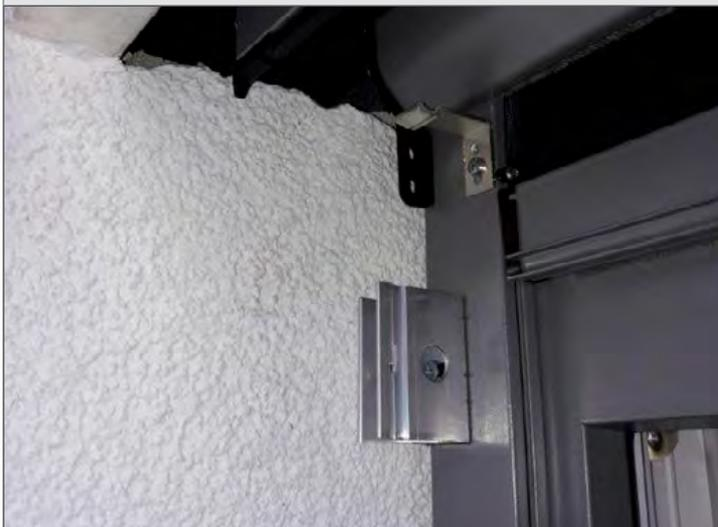
Montageclip der Führungsschienen auf Insektenschutz-Führungsschiene an gewünschter Position aufkleben und mit Schraube fixieren (Schrauben ehest möglich an Aussenkante positionieren).
