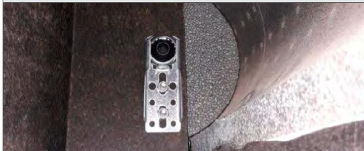
Aufnahme Motorseitig (mit Klammer) und Aufnahme Lagerseite (mit Kugellager) entsprechend positionieren und sicherstellen, dass die Stromzuleitung Motorseitig vorbereitet ist.
