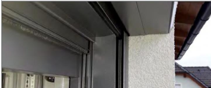
Führungsschienen auf die Montage-Clips stecken und andrücken; Panzer in die Führungsschiene einführen und an der Unterleiste mit einem kleinen Imbus die Arretierung verdrehen. Motor/Panzer nach unten abfahren bis er selbstständig stoppt, dann wieder nach oben bis er selbstständig stoppt – Motor erkennt die Endlagen automatisch.
