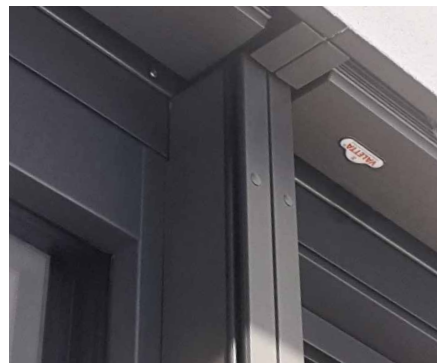
Führungsschienen schlagregensicher mit innovativem koextrudiertem Clip-Keder, welcher für einen nahezu geräuschlosen Lauf des Behangs sorgt.
