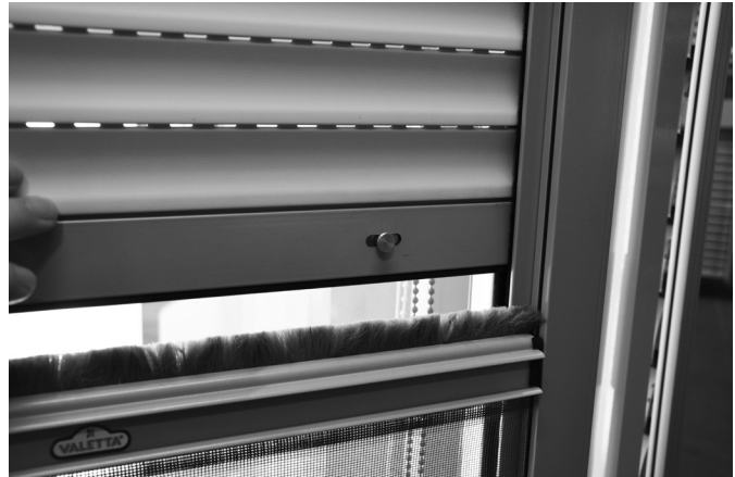
2. PCI über die Endleiste schieben und bis zur Endleiste runter lassen. PCI-Schiene sollte bei der Endleiste hängen bleiben.
