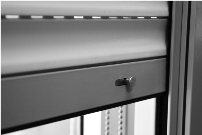
1. Zapfen verschieben damit PCI-Schiene an der Rollladen Endleiste hängen bleibt.
