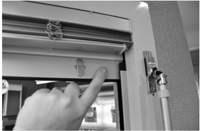
Endleiste tauschen und in die Führungsschienen geben. Kasten wieder verschließen.
