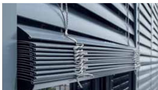
Kompaktes Lamellenpaket
