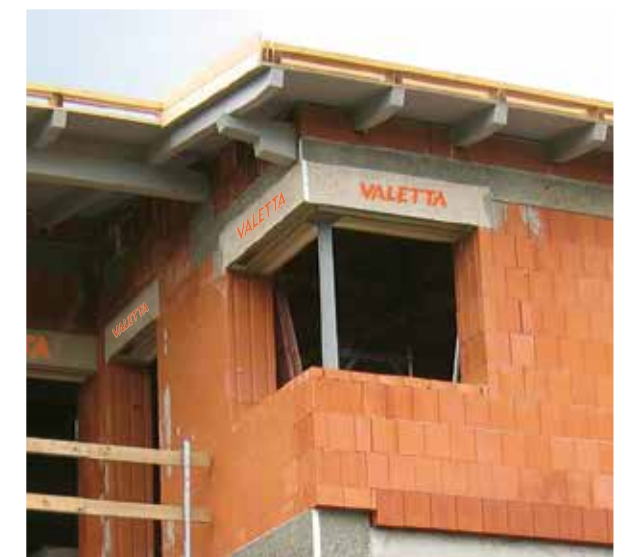
Der Sturzkasten sitzt dort, wo sonst ein Überlager eingebaut wird.
