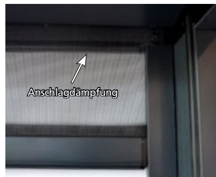
Vorbereitung für Nachrüstung ERCI-H mit Anschlagdämpfung
